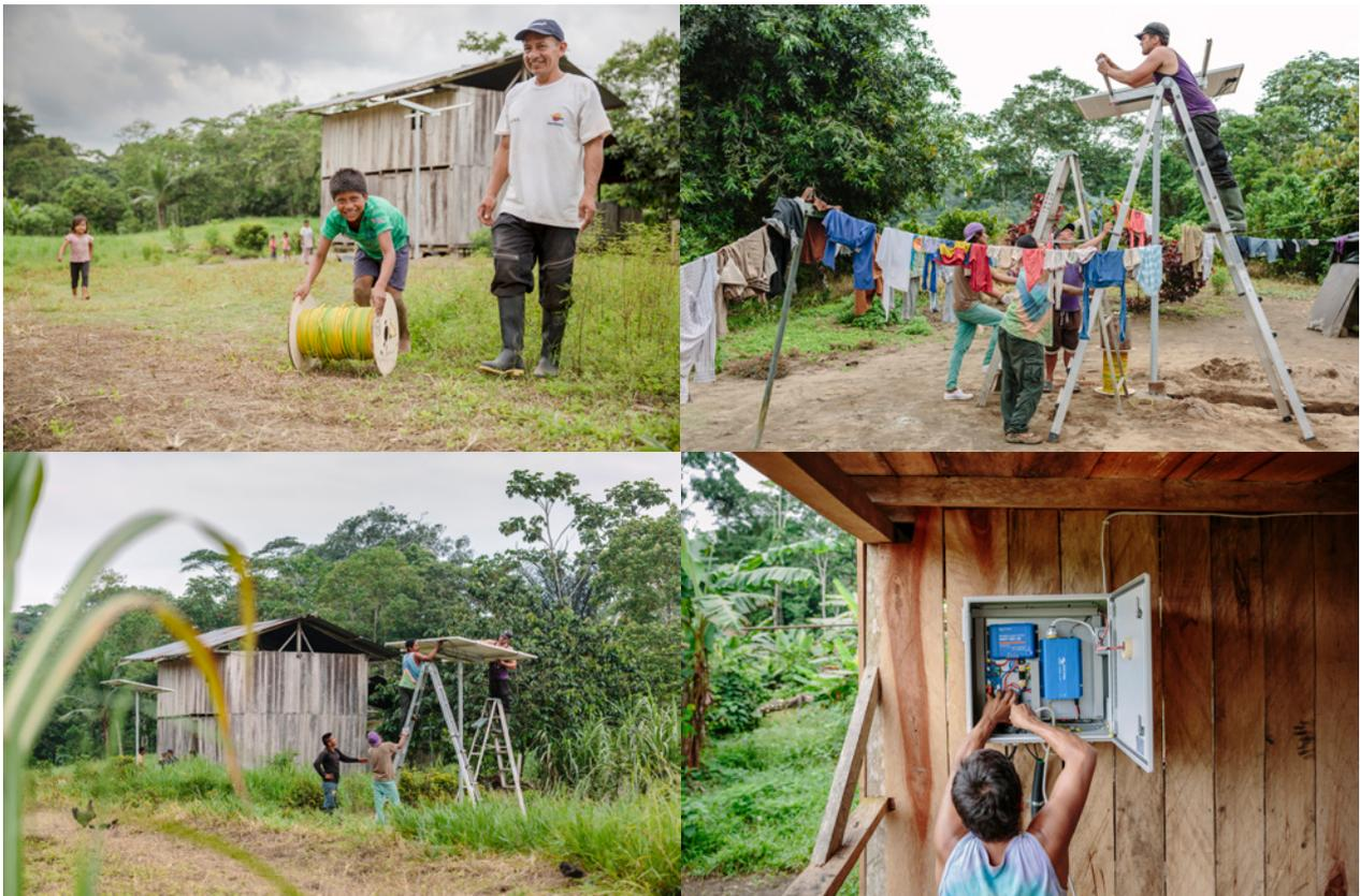
Installation in Bavoroe: Junge aus der Gemeinde mit Erdungskabel / Montage der Solarmodule / ein Schalt-schrank mit elektrischen Komponenten
